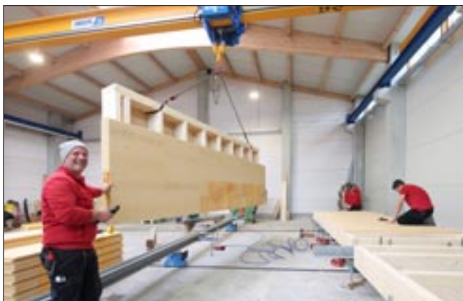
Ende Februar wurde die neue Halle fertiggestellt. Sie bietet ausreichend Platz, auch für größere Bauteile.
