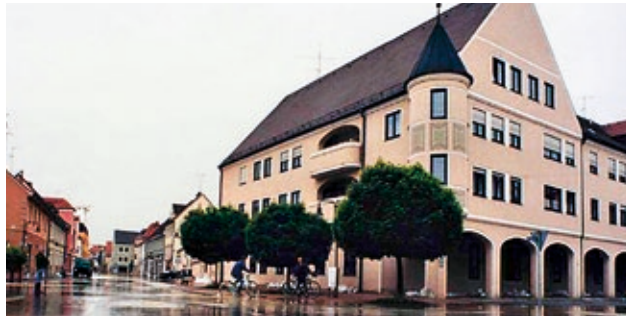
Abb. 8: Eine intakte Kanalisation verringert die Überflutungsgefahr.
