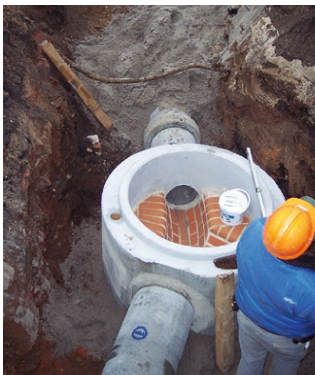
Abb. 28: Kanalerneuerung in offener Bauweise
